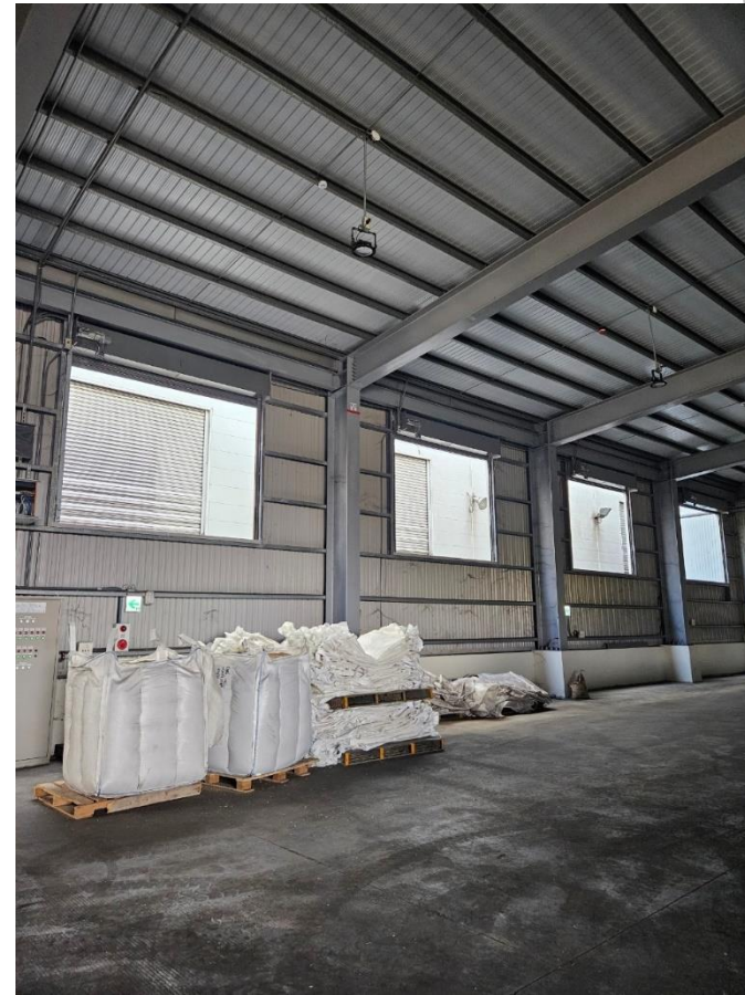
排煙鐵捲門（開）
