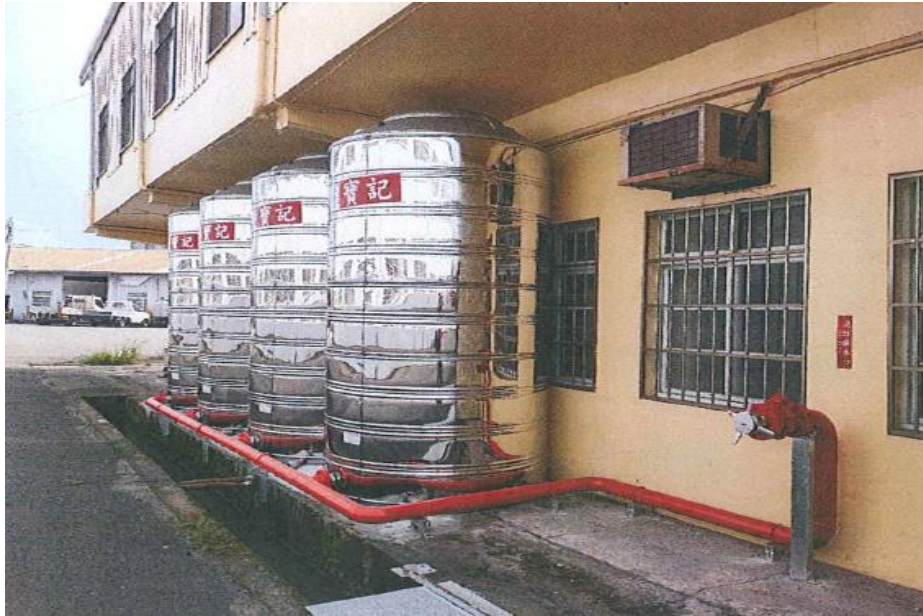
自設水塔外觀
